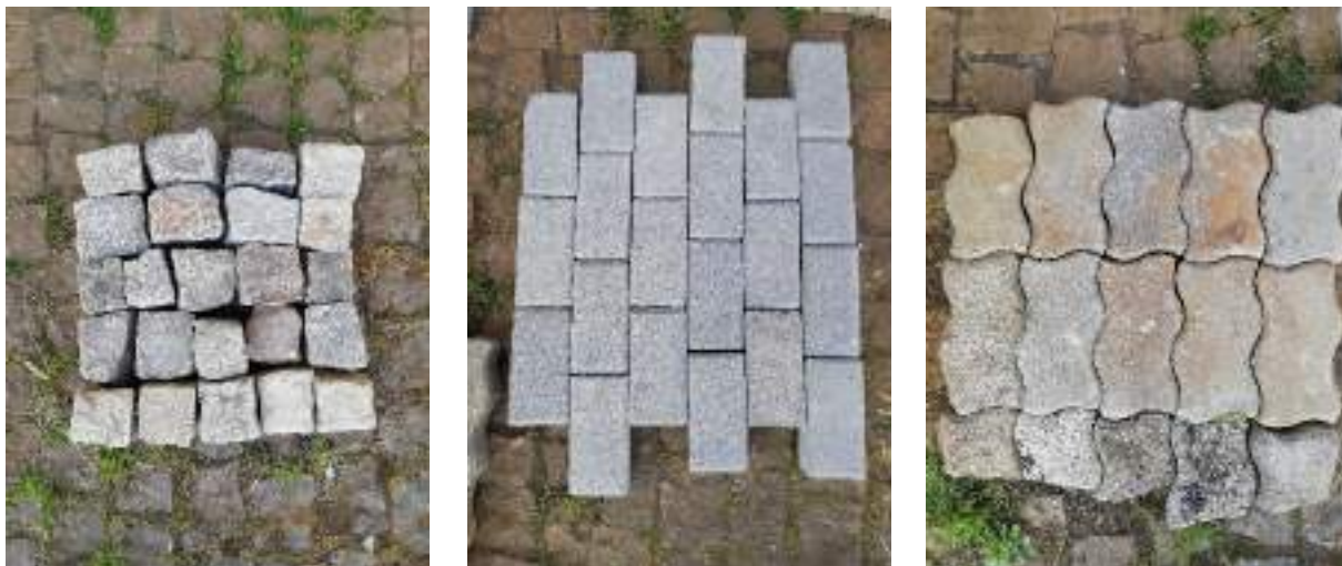
Fig. 56 - Tipos de pavimentos utilizados en zonas urbanas
